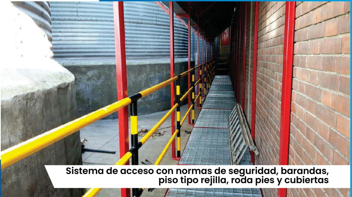
**Sistema de acceso con normas de seguridad, barandas, piso tipo rejilla, roda pies y cubiertas**
